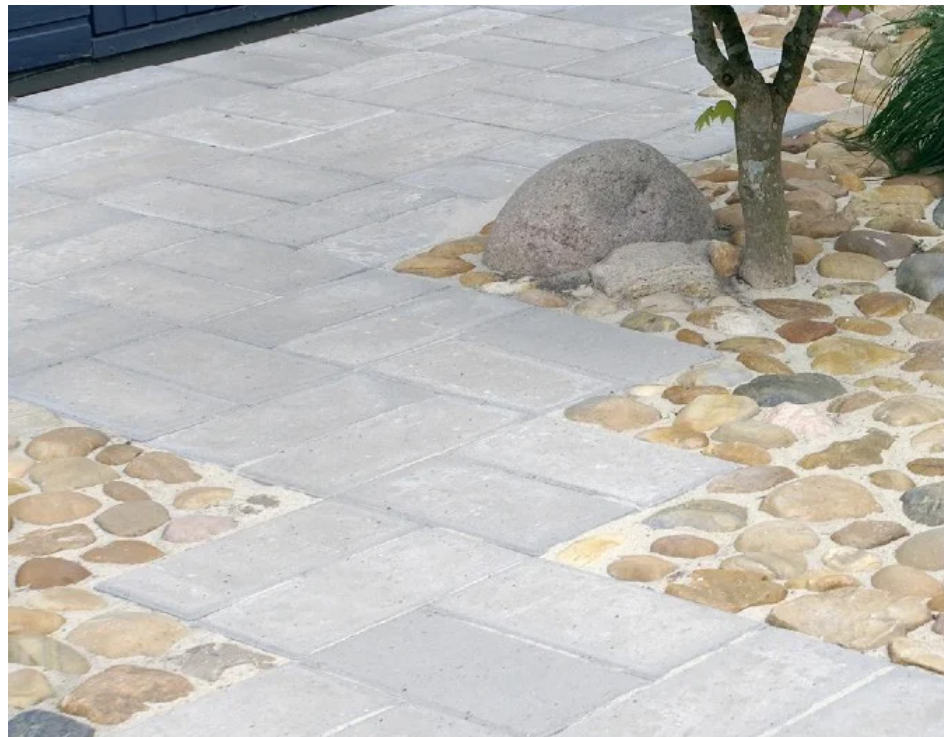
Betonfliser 40*20 cm ved nedslagene
